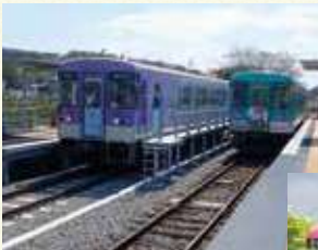
法華口駅の行違い設備
